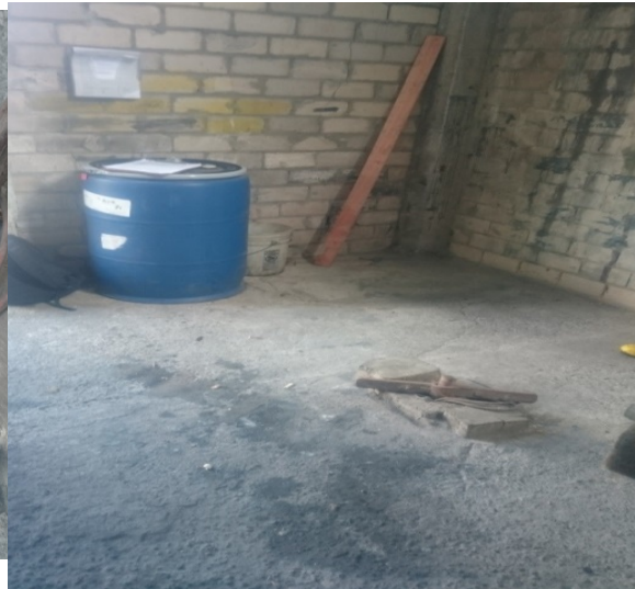
Foto 9. Almacenamiento de cromo cercano al pozo pz-19-0018
